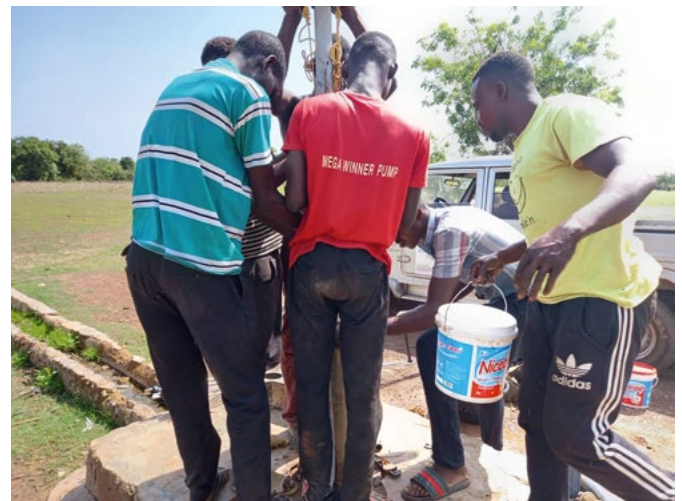
Reparatur des Brunnens
