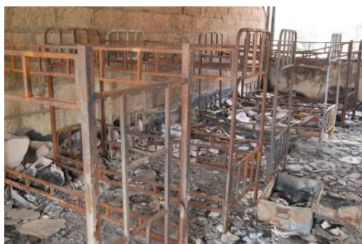
Die verwüsteten Räume des Internats
