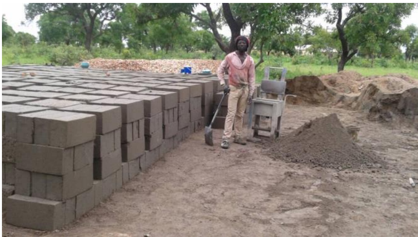
Ziegelherstellung für den Bau der Junior High School
