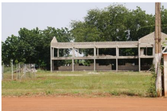
Unterricht auf der Baustelle
