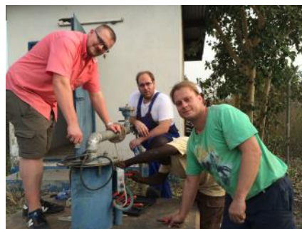
Nicolai Roerkohl, Tobias Althoff, Emos Baba Tayah und Markus Heitkamp (v.l.) bei der Reparatur einer Bohrloch-Stromversorgung
