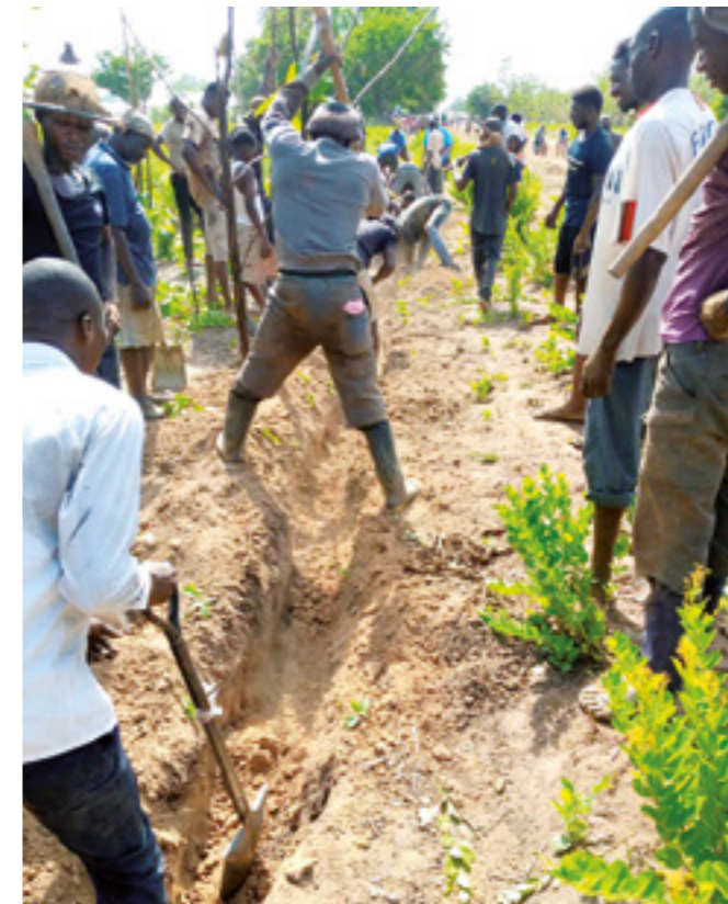
Die Bewohner von Kukuio bauen die Wasserleitung in das „Hexendorf“.
