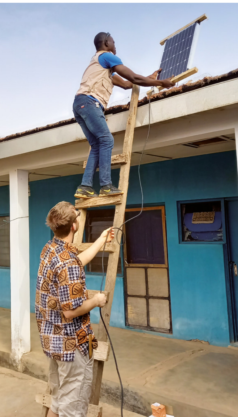
Kai Finkemann mit Helfern bei der Installation der Sonnenkollektoren
