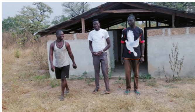
Der fast fertiggestellte Schweinestall
