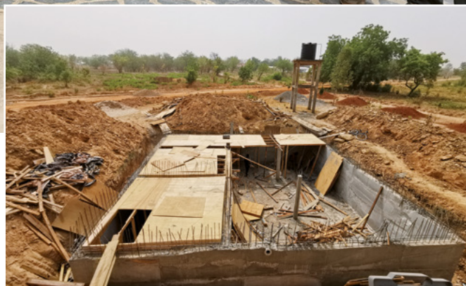
Bau des Wasserreservoirs in Damongo
