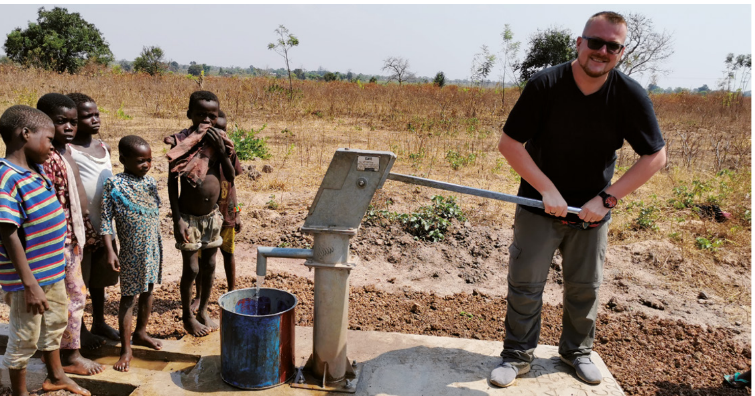
Nicolai Roerkohl überzeugt sich von der Funktionsfähigkeit der Handpumpe am Brunnen in Tidrupe
